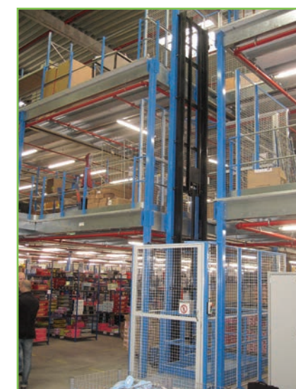
Monte-charges : forte charge
