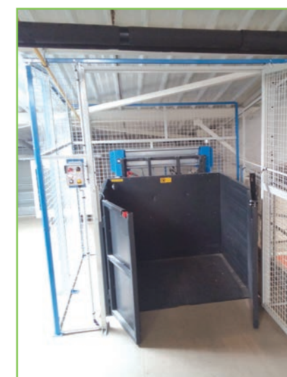
Monte-charges : forte charge
